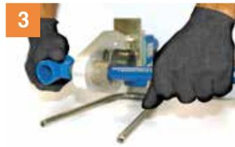
Caliente simultáneamente en la termofusora (portátil o de banco) los elementos a unir hasta que haya cumplido con los tiempos de calentamiento (T1) indicados en la tabla No. 3 "Condiciones para termofusión".
