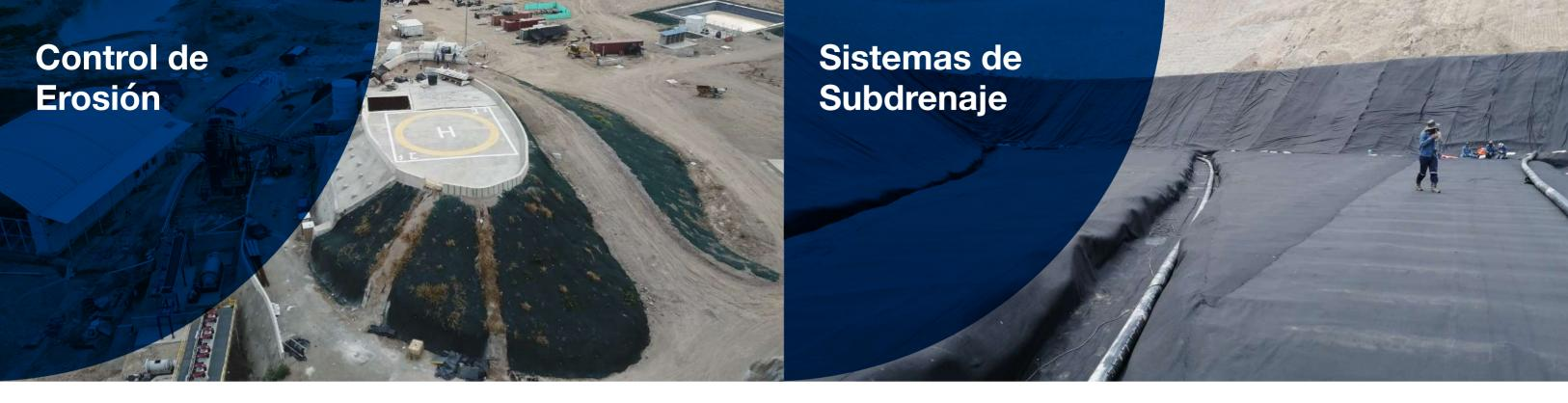
Los procesos erosivos pueden ocurrir en minería durante la exploración, operación y cierre. **Ambientalmente es necesaria la protección y/o revegetación de los taludes** de corte o relleno cuando se construyen facilidades, carreteras de acceso, locaciones, diques, canales, obras hidráulicas y cierres mineros. Para tal fin, es preciso proteger la superficie de suelo, impidiendo la formación de cárcavas y surcos.
