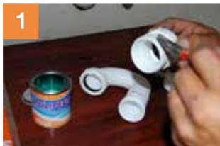
1 Aplicar soldadura en la parte lisa del adaptador.
