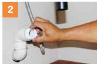
2 Colocar en la campana del codo que viene en la pared.
