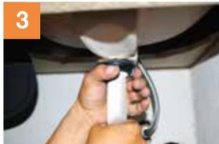
3 Colocar la tuerca de ajuste de abajo hacia arriba.
