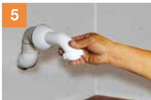
5 Enroscar la segunda parte del sifón al codo de la pared.
