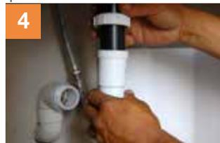
4 Colocar el sifón de abajo hacia arriba y enrosque.
