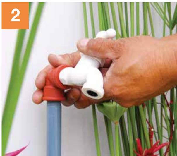
Girar manualmente y ajustar 1/4 de vuelta. No utilice herramientas para hacer el ajuste.
