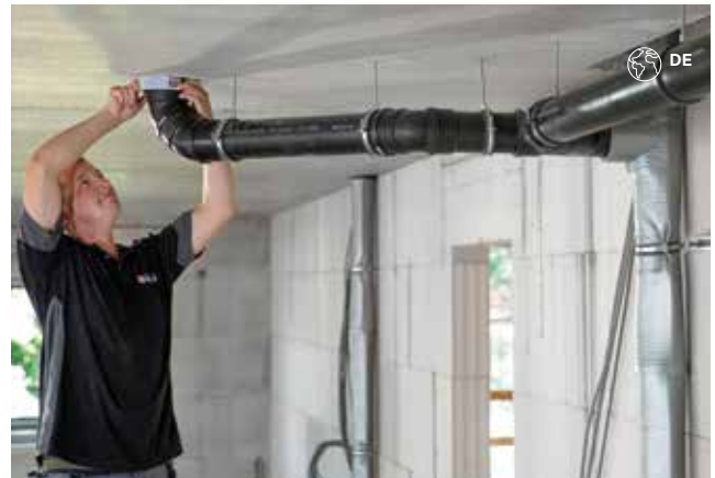
Figur 39: Afløbsinstallation med lydæmpningsslange
