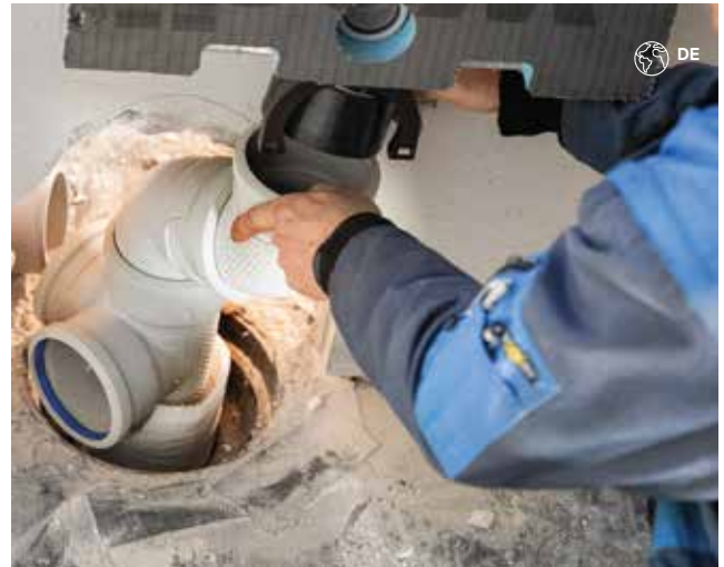
Figur 42: Installation af afløbssystem i betongulv
