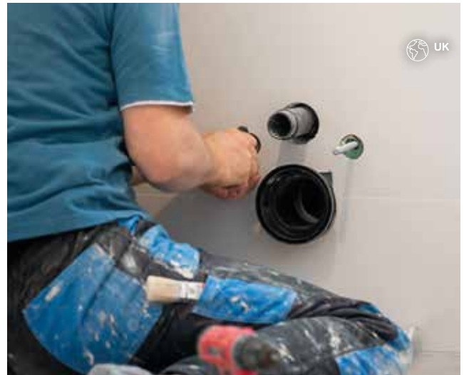
Figur 43: Forberedelse til installation af sanitetskeramik
