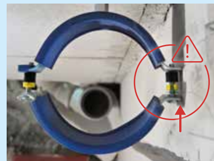
Figur 40: Korrekt justering af rørbærer
