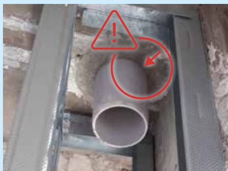
Figur 20: Glemte lydisolering
