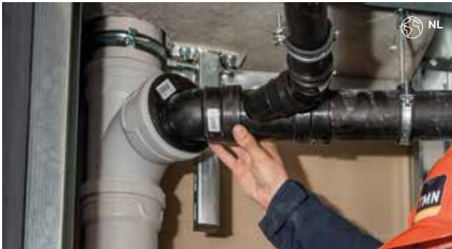
Figur 14: Eksempel på konstruktion af rørbærer
