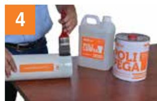
**4** Aplique una capa uniforme de soldadura líquida al exterior del extremo liso del tubo por lo menos en una longitud igual a la campana del tubo o accesorio. Evite el exceso de soldadura.
