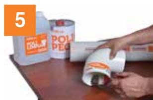
**5** Aplique una capa uniforme de soldadura líquida al interior de la campana del tubo o accesorio con una brocha de cerda natural, cuyo tamaño no debe ser mayor a la mitad del diámetro de la tubería que se está instalando. No use brochas de nylon o sintéticas.
