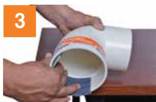
**3** Lije la superficie a conectar. Pruebe en seco la unión de tubos y/o accesorios. Limpie y prepare la superficie a soldar usando un trapo humedecido con solvente limpiador Polilimpia.
