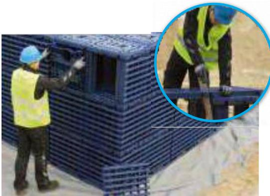
Offene Stellen können mit einer halben Seitenplatte verschlossen werden. Die Seitenplatte ist mithilfe einer Säge mittig zwischen dem Führungs-Doppelsteg in zwei Teile zu sägen.
