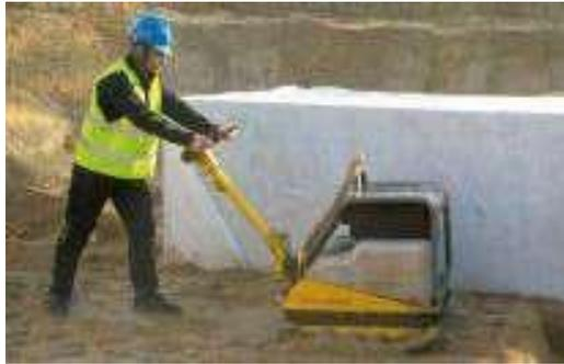
Vor der Verfüllung sind alle Anschlussarbeiten an der Rigole abzuschließen. Dann ist die Rigole seitlich lagenweise zu verfüllen und zu verdichten.
