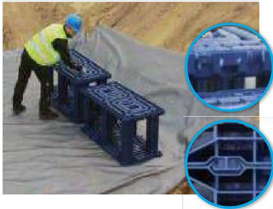
Die Verlegung beginnt für die erste untere Lage mit dem Verbinden des Speicherelementes mit der Bodenplatte. Hierzu ist das Speicherelement mit 6 Säulen in die hierfür vorgesehenen Aussparungen der Bodenplatte einzurasten.
