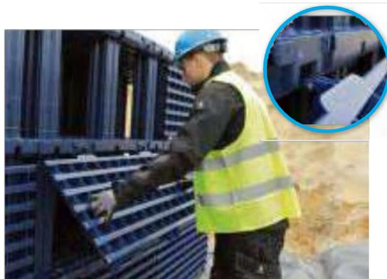
Das Einhängen der Seitenplatten kann durch integrierte Aufhängungen (oberhalb des Wavin Logos auf der Anschlussplatte) einfach durchgeführt werden. Hierzu sind die Seitenplatten an den dafür vorgesehenen Aufnahmen rechts und links jeweils zwischen den integrierten Horizontalverbindern einzuhängen. Nach dem Einhängen können die Seitenplatten einfach losgelassen werden und rasten so durch das Herunterfallen direkt in das Speicherelement ein.
