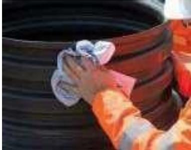
Vor der Montage der Abdeckung ist der Bereich der Dichtfläche auf Beschädigungen zu prüfen und zu reinigen, ggf. sind die Bauteile auszutauschen. Für das Auflager ist eine vollflächige Feinsand- bzw. Splittschicht aufzubringen und zu verdichten. Die Vorschriften und Richtlinien des Straßenbaus sind zu beachten. Für den EVZ-Wert unter der Abdeckung ist die ZTVE-StB 09 zu berücksichtigen.
