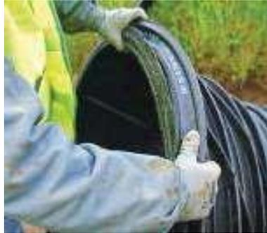
Die Dichtung ist mit der Schrift nach unten ohne Verdrehen in die entstandene Sicke einzulegen. Die Muffe am Schachtboden ist zu reinigen und gleichmäßig mit Gleitmittel zu versehen.
