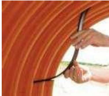
Zur Endmontage des Spannringes ist der in das Schachtröhre ragende Teil des Spannringes gemäß obiger Abbildung gewaltfrei zurück in das Wellental zu drücken. Nach der Montage des Spannringes sollte dieser umlaufend am Schachtröhre anliegen und fest im Wellental sitzen. Die Verschlusskappen der Steigleiterholme sind zu entfernen und später zum Sichern der Steigleiter wieder einzusetzen.
