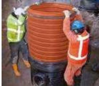
Danach ist das Schachtrohr ohne Verkanten in die Schachtbodenmuffe einzusetzen. Bei einer hydraulischen Montageunterstützung ist zum Schutz der Schachtbauteile ein Kantholz oder eine entsprechende Platte zentral zur Schachtachse aufzulegen. Bei Schächten mit Steigleiter ist ggf. auf eine korrekte Ausrichtung der Steigleitieraufnahme zu achten.
