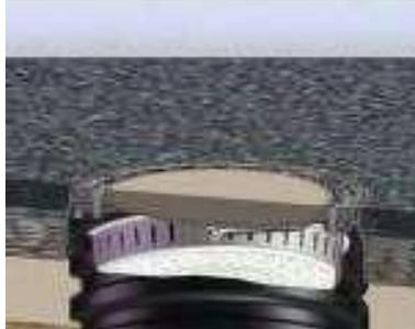
Die Abdeckung ist auf das vorbereitete Auflager zu legen. Bei Einsatz eines Dichtringes (Art.-Nr. 4023826) ist dieser im ersten Wellental außen einzulegen und mit Gleitmittel zu versehen. Eine direkte Auflage auf den Konushals ist durch eine Setzungsfuge von ca. 10mm zu vermeiden.
