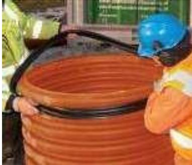
Zur Verbindung von Schachtrohr und Schachtboden, sowie Schachtrohr und Schachtkanus sind jeweils im gesäuberten, letzten Wellental an den Enden des Schachtrohres die Dichtungen wie in der Abbildung dargestellt einzulegen. Für die Installation des Dichtringes ist das jeweilige Label am Dichtring zu beachten.
