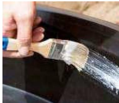
Bevor das Schachtrohr auf den Schachtboden aufgesetzt werden kann, ist der Muffenbereich des Schachtbodens gleichmäßig und umlaufend mit Gleitmittel zu versehen.
