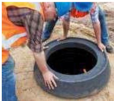
Der Auflagering ist schließlich auf das Auflager aufzusetzen. Hierbei ist eine Setzungsfuge von 20mm bis max. 50 mm zu realisieren. Punktlasten und Hohlräume sind grundsätzlich zu vermeiden!
