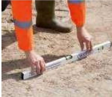
Die Aufstandsfläche des Schachtbodens ist gemäß DIN EN 1610 „Bettung Typ 1“ auszuführen. Hierzu ist das Auflager für den Schachtboden durch eine mindestens 10cm dicke, verdichtete Sauberkeitsschicht zu bilden.
