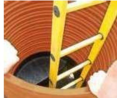
Nach der Spannringmontage ist die Steigleiter durch die Steigleiterholmaufnahmen zu schieben. Die Holmaufnahmen sollen zwischen der letzten und vorletzten Sprosse liegen, dann sind sie mit den Verschlusskappen wieder zu verschließen. Das Schachtröhre inklusive einseitig fixierter Leiter ist analog Schritt 5-1 O der Einbauanleitung auf den Schachtboden aufzusetzen.
