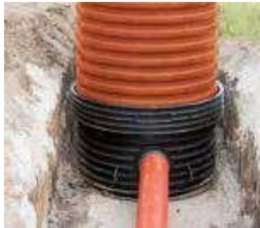
Das Spitzende des anzuschließenden Rohres ist gemäß Herstellerangaben zusäubern, anzufasen und gleichmäßig mit Gleitmittel zu versehen. Nach dem Einstecken ist die Rohrführung gemäß den Planungsvorgaben auszurichten. Hierzu kann das Rohr aufgrund von integrierten Kugelgelenken stufenlos in die erforderliche Richtung abgewinkelt werden. Es lassen sich hierbei sowohl Richtungsänderungen im Bereich von 15° als auch Gefälle von bis zu 13 % realisieren.
