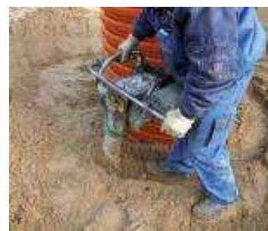
Abschließend ist der Schacht gemäß DIN EN 1610 in Lagen von max. 30cm zu verfüllen und mit entsprechendem Verdichtungsgerät zu verdichten. Die Proctordichte bei der Verdichtung muss in Gebieten ohne Verkehrslast mindestens 92 %, in Gebieten mit PKW- oder Schwerlastverkehr mindestens 95 % betragen.
