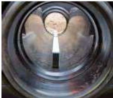
Anschließend ist der Schachtboden auszurichten und entsprechend dem erforderlichen Gefälle im Gerinne einzubetten. Bei Bedarf ist der Schachtboden in die Bettung einzulassen.
