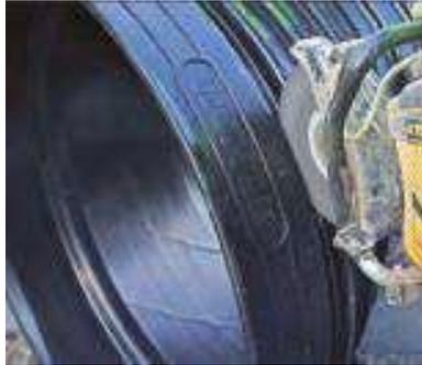
Bei sehr geringen Einbautiefen kann die Muffe vom Konus abgetrennt werden. Hierzu ist mit einer geeigneten Säge die Muffe an der Markierung vom Konus abzuschneiden. Grate und scharfe Kanten sind zu entfernen und die entstandene Dichtkammer zwischen den Rippen zu reinigen. Es ist darauf zu achten, dass die Rippen beim Ablängen nicht beschädigt werden.
