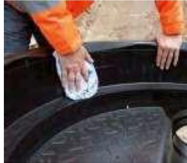
Vor dem Einbau der Schächte sind zudem alle Bauteile auf Beschädigungen und Verunreinigungen zu überprüfen. Verunreinigte Dichtelemente und Schachtkomponenten sind zu säubern. Beschädigte Bauteile sind gegebenenfalls auszutauschen. Die Dichtelemente sind im Anschluss auf korrekten Sitz zu überprüfen.
