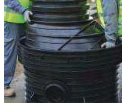
Der Konus ist gleichmäßig und ohne Verkanten in den Schachtboden zu setzen.
