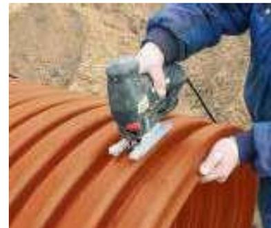
Für den weiteren Schachtaufbau ist das Schachtrohr, falls erforderlich, entsprechend der gewünschten Einbautiefe abzulängen. Hierzu ist das Schachtrohr mit Hilfe einer Säge auf einer Außenwelle (äußerster Profilpunkt) zu durchtrennen und die Trennkante sauber umlaufend zu entgraten.
