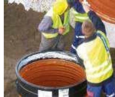
Zur Verlängerung von Tegra 1000 PP Schachtrohren kann ggf. eine Schachtrohrverlängerung eingesetzt werden. Die Verbindung zwischen Schachtrohrverlängerung und Schachtrohr hat analog zur Verbindung Schachtboden - Schachtrohr zu erfolgen.
