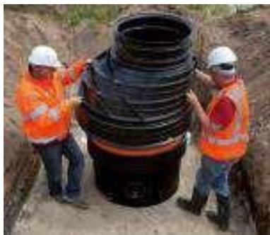
Der Schachtkanus ist abschließend gemäß der Steigleiterposition im Schachtrohr auszurichten und ohne Verkanten aufzusetzen. Für die Variante Schachtkanus mit Spitze erfolgt der Einbau analog zu Schritt 7-8. Ein zusätzliches Aufsetzen des Konus ist nicht mehr erforderlich. Bei einer Montageunterstützung mit hydraulischem Gerät ist auch hier zum Schutz der Schachtbauteile ein Kantholz oder eine entsprechende Platte zentral zur Schachtachse aufzulegen.
