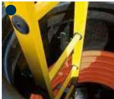
Beim Aufsetzen des Konus ist darauf zu achten, dass die Steigleiter nicht mit diesem kollidiert. Ein gewaltsames Aufsetzen ist in jedem Fall zu vermeiden. Ferner ist darauf zu achten, dass die Steigleiter gleichmäßig durch den Konushals geführt wird.
