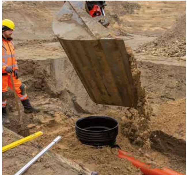
Figura 42: Instalación de tubería de PVC.
