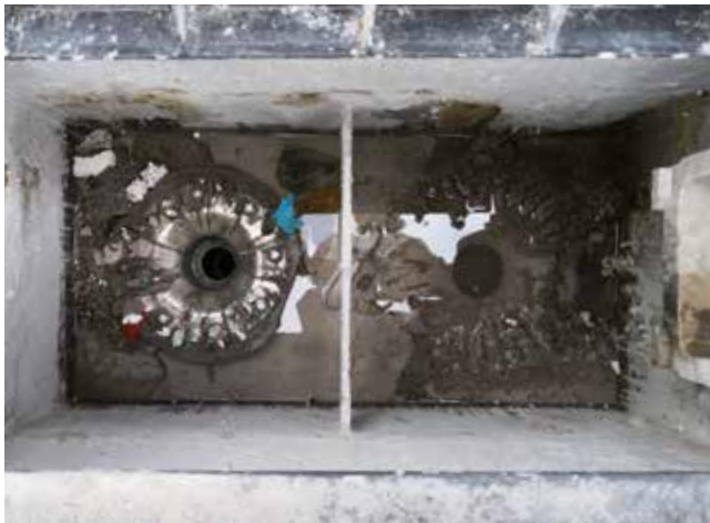
Figura 53: Mantenimiento periódico a salidas de techo.
