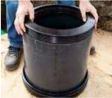
Das Schachtrohr ist je nach Einbautiefe ggf. zu kürzen, zu entgraten und die Teleskopmanschette ggf. zu reinigen. Die Manschette ist dann bis zum Anschlag in das Schachtrohr einzustecken. Hierbei ist kein Gleitmittel zu verwenden. Das angefasste Teleskoprohr der Teleskopabdeckung ist dann gleichmäßig mit Gleitmittel zu versehen und in die Manschette einzuführen.
