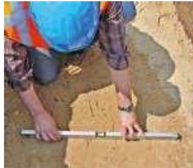
Die Aufstandsfläche des Schachtbodens ist gemäß **DIN EN 1610** „BettungTyp1“ auszuführen. Zur Vermeidung von Punktlasten oder Hohlräumen ist die Aufstandsfläche entsprechend der Schachtbodenunterseite vorzuformen oder bei der Verfüllung auf eine entsprechende Unterfütterung zu achten.
