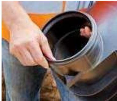
Vor dem Einbau der Schächte sind alle Bauteile auf Beschädigungen und Verunreinigungen zu überprüfen. Verunreinigte Dichtelemente und Schachtkomponenten sind zu säubern. Beschädigte Bauteile sind gegebenenfalls auszutauschen. Die Dichtelemente sind auf korrekten Sitz zu überprüfen.
