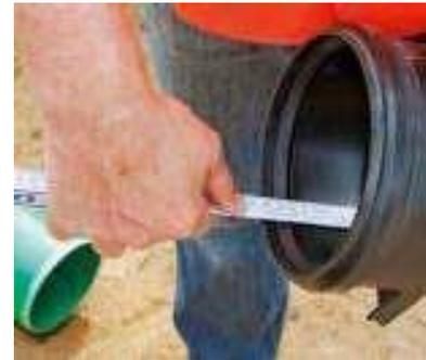
Die Einstecktiefe (Muffentiefe des Schachtbodens) ist auf dem Spitzende der anzuschließenden Schmutz- oder Regenwasserleitung zu markieren. Anhand der Markierung kann kontrolliert werden, ob das Rohr bis zum Anschlag in den Schachtboden eingeschoben worden ist. Das Spitzende des anzuschließenden Rohres ist gemäß Herstelleranweisung anzufasen und zu entgraten.
