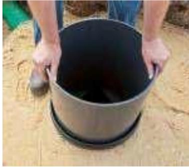
Das angefaste Ende des Schachtrohres ist bis zum Anschlag (Markierung) in den Schachtboden einzustecken. Die Baugrube ist lagenweise (30cm) gemäß DIN EN 1610 weiter zu verfüllen und mit leichtem Verdichtungsgerät zu verdichten.
