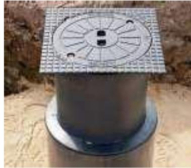
Durch das Teleskoprohr ist nun eine exakte Höhenanpassung entsprechend den Planungsvorgaben möglich. Hierbei ist auf eine Mindesteinstecktiefe des Teleskoprohres in der Teleskopmanschette von min. 100mm zu achten. Der Schacht ist nun lagenweise (max. 30cm) gemäß DIN EN 1610 weiter zu verfüllen und zu verdichten. Es gelten die Dichtheitsanforderungen der DIN EN 13598-2 für Teleskopteile und der DIN EN 1610.
