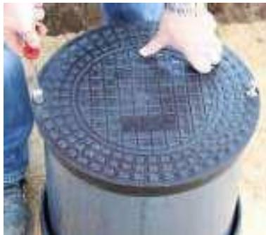
Die Außensechskantschrauben sind nach dem Aufsetzen der Abdeckung im Schachtrohr zu verschrauben. Hierbei ist die Abdeckung auf das Schachtrohr zu drücken oder zu fixieren.
