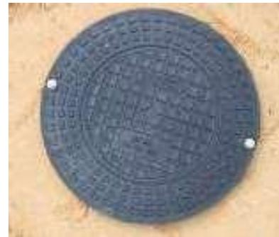
Gemäß DIN EN 124 ist die Kunststoffabdeckung A 15 aus PP ausschließlich für den begehbaren Bereich der Gruppe 1 einzusetzen. Die Oberfläche kann nun gemäß den Planungsvorgaben erstellt werden.
