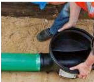
Das Spitzende des anzuschließenden Rohres ist ggf. zu säubern und gleichmäßig mit Gleitmittel zu versehen. Je nach Verlegesituation ist der Schachtboden, unter Berücksichtigung der im Schachtboden angegebenen Fließrichtung, auf das Spitzende des Rohres zu schieben oder das Rohr bis zum Anschlag (Markierung) in den Schachtboden einzustecken.
