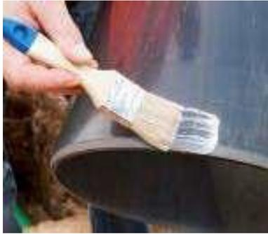
Das Schachtrohr ist gegebenenfalls zu säubern und am angefasten Ende gleichmäßig mit Gleitmittel zu versehen. Zur Kontrolle der Einstecktiefe ist die Muffentiefe auf dem Schachtrohr zu markieren.
