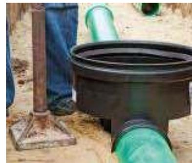
Der Schachtboden und die angeschlossenen Rohre sind gemäß **DIN EN 1610** mit Sand, Kies oder sandigem Kies (Größtkorn 20 mm) zu verfüllen. Hierbei ist darauf zu achten, dass der Schachtboden lagenweise (max. 30cm) von allen Seiten verfüllt und mit leichtem Verdichtungsgerät verdichtet wird. Es ist eine Proctordichte von  $D_{pr} 97\%$  zu erreichen.
