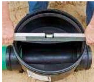
Der Schachtboden ist nun gemäß den Planungsvorgaben auszurichten. Hierbei ist der Schachtboden entsprechend dem erforderlichen Gefälle im Gerinne auszurichten. Zusätzlich ist darauf zu achten, dass die Schachtrohrmuffe senkrecht zur Rohrachse steht.
