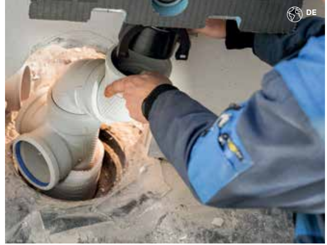
Şekil42: Zemin döşemesi için kanalizasyon sisteminin kurulması
