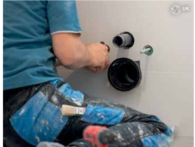
Şekil43: Seramikler için montaj hazırlığı
