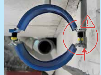
Şekil 40: Boru braketlerinin doğru hizalanması
