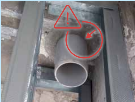
Şekil 20: Unutulan yapı kaynaklı ses dekuplajı
