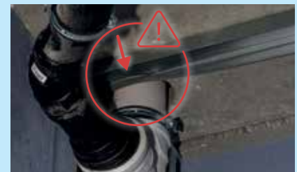
Şekil 41: Boru braketlerinin doğru hizalanması
