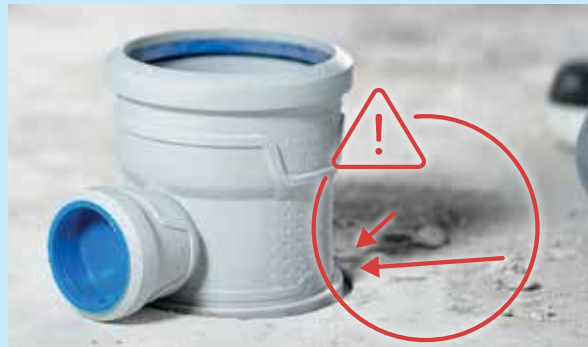
Şekil 21: Yapı kaynaklı bir ses köprüsü olarak bina molozları
