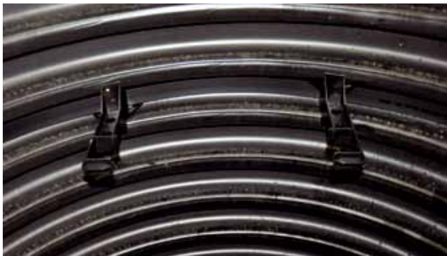
Redeli kinnituse eelnev paigutamine tõusutorusse
