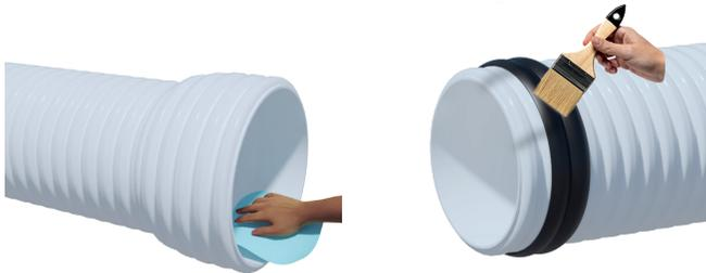
Figura 6.6. Colocación de lubricante
