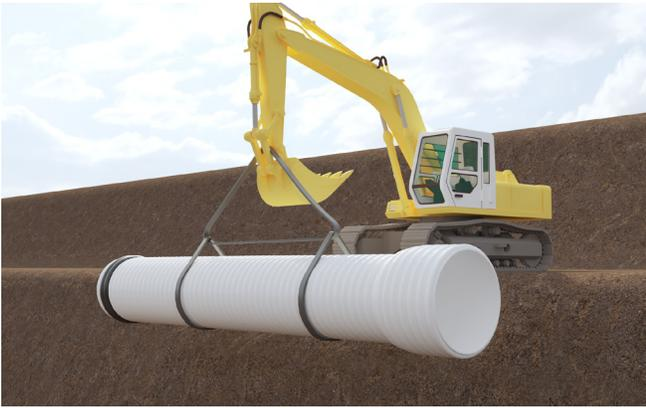
Figura 6.2. Manipulación en zanja
