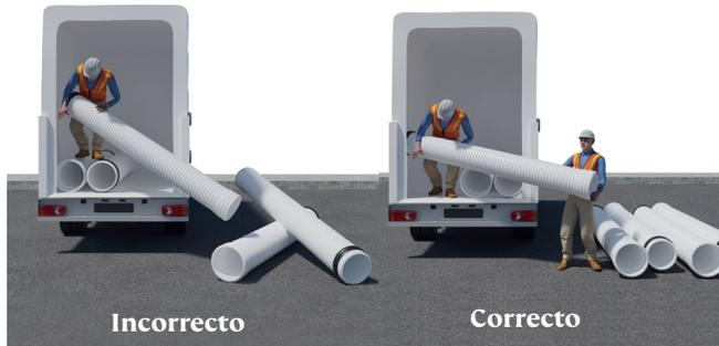
Figura 5.8. Descarga del camión
