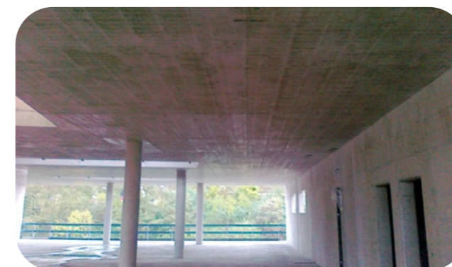
Hotová stropní deska
