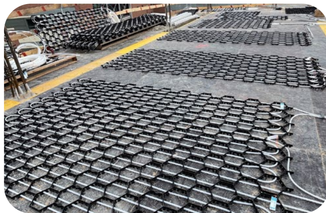
Registrové panely Wavin Comfia CW-90 položené na bednění desek
