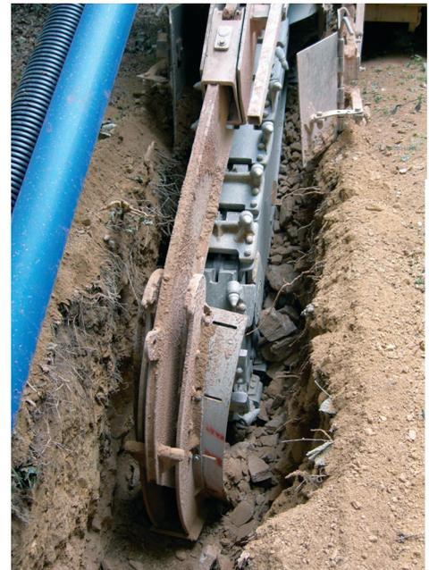
Alternative, sandbettfreie Verlegungen von Wavin SafeTech RC<sup>n</sup> – Rohren
