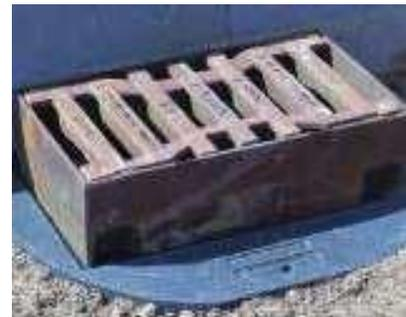
Fertig montierter Ablaufrost mit Kunststofflastaufnahmering.
