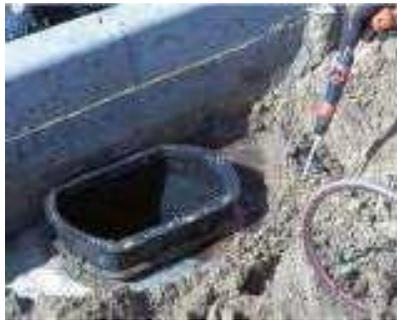
Zur Vermeidung von Hohlräumen und für eine optimale Verdichtung wird das Einschlämmen des Bodens im direkten Seitenbereich empfohlen. Für einen sicheren Lastabtrag ist ein geeignetes Auflager herzustellen. Das Auflager aus verdichtungsfähigem Material ist gemäß DIN EN 1610 bis zu einer Proctordichte von min. 95 % zu verdichten.
