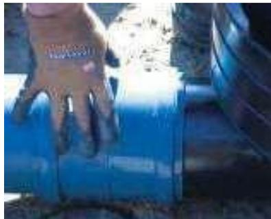
Das Spitzende des Straßenablaufgrundkörpers ist mit dem vorgesehenen Rohrsystem zu verbinden. Hierbei wird die Muffe des Rohrsystems auf das Spitzende DN/OD 160 geschoben. Die Verlegeanleitungen des Rohrherstellers sind zu berücksichtigen. Nach dem Herstellen des Rohranschlusses kann der Grundkörper in die gewünschte Richtung ausgerichtet werden.
