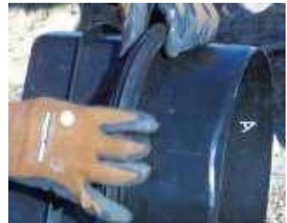
Das symmetrische Dichtelement ohne verdrehen oder überdehnen in das dafür vorgesehene Rippental des Ablaufoberteils einlegen. Je nach Gussaufsatz ist das Oberteil 300x500 oder 500x500 rund einzusetzen.
