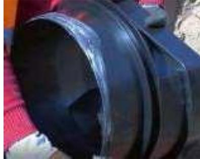
Je nach Gussaufsatz ist das Oberteil 300 x 500 oder 500x 500 rund einzusetzen. Das Ablaufoberteil ist umlaufend mit Gleitmittel einzustreichen.
