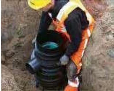
Der Tegra Straßenablauf mit Schlammfang kann direkt, ohne den Einsatz von Ortbeton, auf das vorbereitete und verdichtete Auflager gesetzt werden. Das Auflager ist gemäß DIN EN 1610 „Bettungstyp 1“ auszuführen. Bei ungeeigneten Böden ist eine verdichtete Sauberkeitsschicht gemäß DIN EN 1610 von min. 10cm einzubringen.
