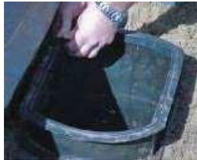
Zur lastenkoppelten Abdichtung der Verbindung zwischen Straßenablauf und Kunststofflastaufnahmering das Dichtelement ohne den Einsatz von Gleitmittel aufziehen.
