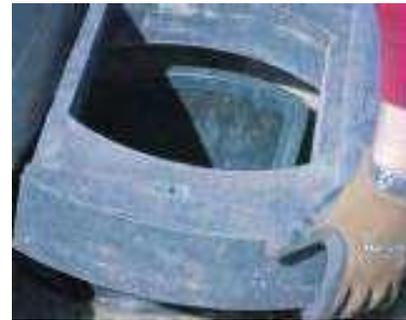
Der Kunststofflastaufnahmering wird auf das verdichtete Auflager aufgesetzt. Je nach Gussaufsatz wird der passende Lastaufnahmering aufgesetzt. Beim Einsatz des Kunststofflastaufnahmeringes und einem entsprechend ausreichend verdichtetem Auflager kann der Lastabtrag direkt ohne Einsatz von Ortbeton ins Erdreich erfolgen. Punktlasten und Hohlräume sind zu vermeiden.
