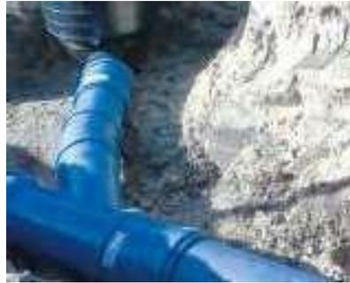
Ausrichten des Straßenablaufs und Anschluss an die Sammelleitung. Hierbei ist auf das vorgesehene Gefälle der Anschlussleitung zu achten, um Gegen-gefälle zu vermeiden.
