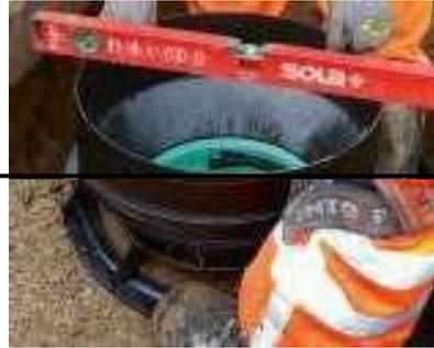
Der Straßenablauf ist entsprechend den Planungsvorgaben auszurichten. Hierbei ist sowohl auf die vorgegebene Einbautiefe als auch auf den Rohranschlussstutzen zu achten. Hierzu kann der Straßenablauf mithilfe der Fußstützen fixiert werden und mit geeignetem Bettungsmaterial bis ca. 10 cm unter dem Ablaufstutzen verfüllt und gemäß Vorgabe verdichtet werden. Es ist darauf zu achten, dass keine Hohlräume entstehen.
