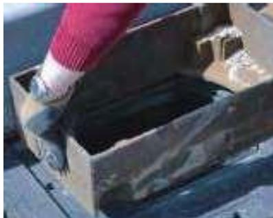
Auf die Lastaufnahmeringe können handelsübliche Gussaufsätze gemäß DIN 19583 (500/500) und DIN 19594 (300/500) aufgesetzt werden.
