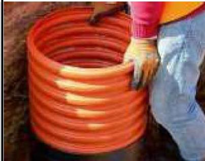
Die minimale Baulänge ist hierbei 120 mm. Die Dichtungen sind innen und außen zu montieren. Die Innenseite ist vor der Montage der Dichtung mit Gleitmittel zu versehen. Das Wellrohr wird mit dem Teil der außen angebrachten Dichtung in das Bodenteil gesteckt.
