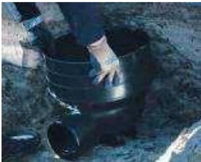
Der Straßenablaufgrundkörper kann direkt, ohne den Einsatz von Ortbeton, auf das Auflager gesetzt werden. Das Auflager ist gemäß DIN EN 1610 „Bettungstyp 1“ auszuführen. Bei ungeeigneten Böden ist eine verdichtete Sauberkeitsschicht gemäß DIN EN 1610 von min. 10cm einzubringen.
