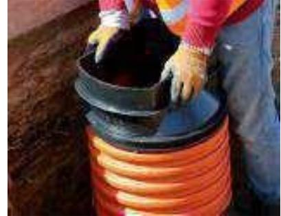
Vor dem Einstecken des Ablaufoberteils in den Straßenablaufgrundkörper ist die Dichtung umlaufend mit Gleitmittel einzustreichen. Die Steckverbindung ist ohne Verschmutzung von Hand herzustellen. **Es ist auf die Einstecktiefenmarkierung zu achten.**
