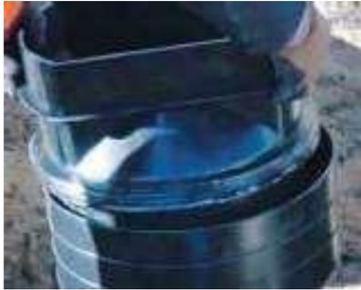
Vor dem Einstecken des Ablaufoberteils in den Straßenablaufgrundkörper ist die Dichtung umlaufend mit Gleitmittel einzu-streichen. Die Steckverbindung ist ohne Verschmutzung von Hand herzustellen. Es ist auf die Einstecktiefenmarkierung zu achten.
