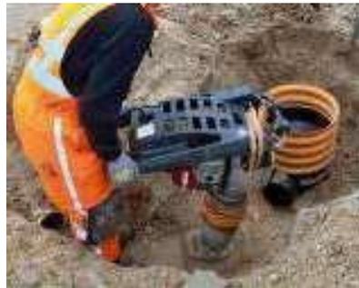
Der Straßenablauf kann nun bis zum Ablaufstutzen mit geeignetem Material verfüllt und von Hand oder mit leichtem Gerät bis zu einer Proctordichte von min. 95 % verdichtet werden.
