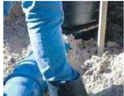
Nachdem der Straßenablauf angeschlossen und ausgerichtet ist, kann der Grundkörper und die Anschlussleitung mit geeignetem Material verfüllt und von Hand oder leichtem Gerät bis zu einer Proctordichte von min. 95 % verdichtet
