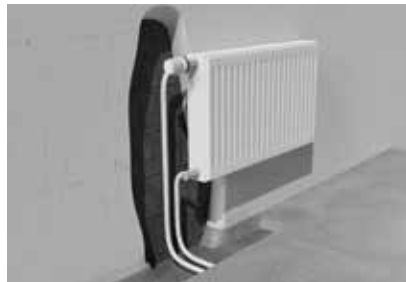
47. ábra: Példák radiátorok felszerelésére „Eurokónuszos” menetes csatlakozóval
