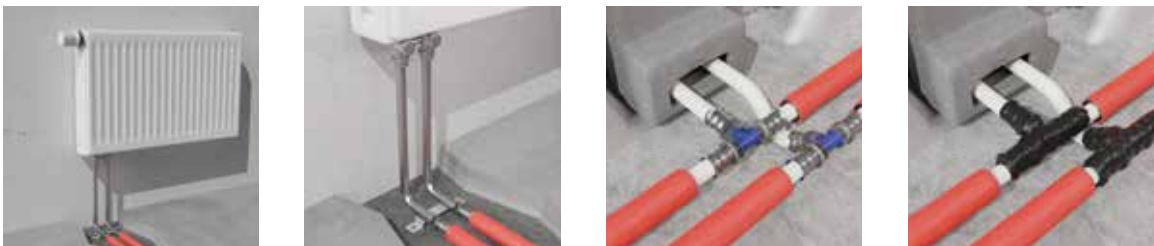
49. ábra: Radiátor csőcsatlakozás hajlított csatlakozókkal
