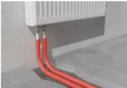
47. ábra: Példák radiátorok felszerelésére „Eurokónuszos” menetes csatlakozóval
