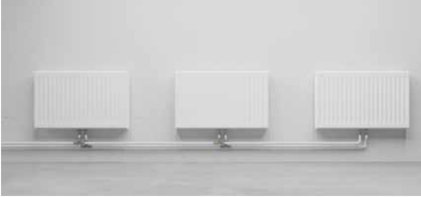
46. ábra: Kétsöves radiátoros fűtés
