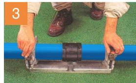
3 Ubique el tubo en el dispositivo con mordazas de alineación, con el accesorio colocado hasta el tope. "No fuerce más allá del tope". Ajuste las mordazas.
