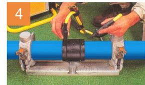
4 Conecte el cable a la fuente de energía.
