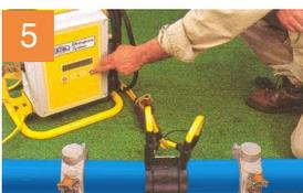
5 Dé energía a la unidad de control mediante el botón correspondiente.
