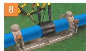
8 Durante la misma; se notará un movimiento ascendente de los "Testigos de Fusión" del accesorio. De no aparecer ningún inconveniente que altere el ciclo, en el visor se indicará "fusión correcta". De aparecer un mensaje de error, se debe repetir absolutamente toda la operación desde el numeral 1.
