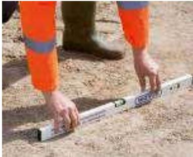
Die Verlegung von Acaro PP SN12 ist gemäß DIN EN 1610 auszuführen. Hierzu ist ein Auflager aus Rundkorn oder Brechsand plan herzustellen. Für Rundkorn gilt in Abhängigkeit von der Rohrnennweite eine maximale Korngröße von 22mm bis DN/OD200 und max. 40mm bis DN/OD500. Gebrochene Baustoffe haben eine Korngröße von 11 mm nicht zu überschreiten.
