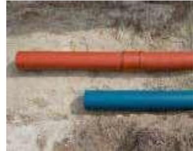
Zwischen der Verlegung und der anschließenden Verfüllung sind die Rohre entsprechend den Planungs- und Herstellervorgaben in Höhe und Orientierung zu fixieren. Um dies zu erzielen kann eine stetige Sichtkontrolle, Sandkegelschüttung oder zum Beispiel Einpfählen vorgenommen werden.
