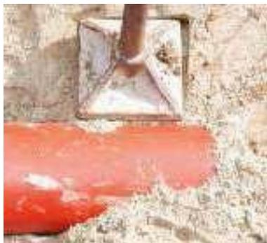
Schließlich ist der Rohrgraben gemäß DIN EN 1610 lagenweise in Schichten von maximal 30cm Höhe gleichmäßig zu verfüllen und verdichten. Hierbei ist die Seitenverfüllung und Verdichtung vor allem im Kämpferbereich sorgfältig und mit leichtem Verdichtungsgerät auszuführen.
