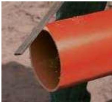
Ferner ist das Rohr an der Schnittstelle wieder sorgfältig umlaufend z.B. mit einer groben Feile anzufasen. Die Einstecktiefe des Spitzendes in die Muffe ist anhand einer Einstecktiefenmarkierung nach dem Ablängen mittels eines Zollstocks abzumessen und zu Kontrollzwecken am Spitzende des anzuschließenden Rohres anzuzukzeichnen. Auf diese Weise kann überprüft werden, ob das Spitzende vollständig eingeschoben wurde.
