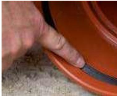
Vor dem Einbau sind alle Bauteile auf Unversehrtheit zu überprüfen und ggf. zu reinigen. Das Spitzende sowie die Muffeninnenfläche müssen sauber und frei von Beschädigungen sein, sonst ist das Rohr zu reinigen oder ggf. auszutauschen. Der korrekte Sitz der Dichtungen in der Muffe ist zu überprüfen.
