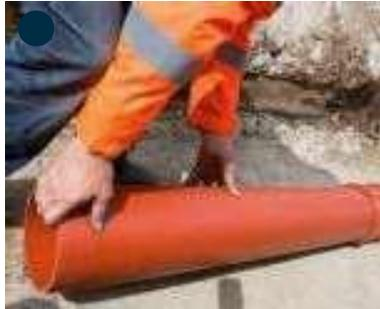
Rohre kleiner Nennweiten sind dann leicht von Hand zusammenschieben. Hierbei sind zudem geringe Richtungsänderungen durch eine Abwinkelung von max. 0,5° in der Muffe realisierbar. Dies entspricht 5cm Auslenkung auf 5 m. Die Lage des Rohres ist zu überprüfen und nach Herstellung der Verbindung gegebenenfalls entsprechend zu korrigieren.
