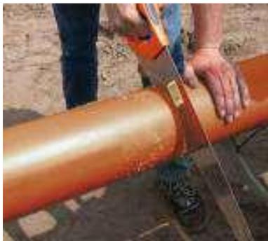
Bei Bedarf können Acaro PP SN12 Rohre auch bauseits auf die erforderliche Länge gekürzt werden. Hierzu ist das Rohr mit einer feinzahnigen Säge senkrecht abzulängen. Formteile dürfen nicht gekürzt werden. Nach dem Kürzen sind Grate und Unebenheiten mit einem geeigneten Werkzeug wie beispielsweise einem Schaber zu entfernen.
