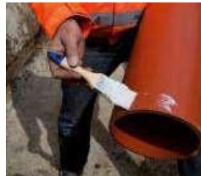
Das markierte Spitzende ist dann umlaufend mit Gleitmittel zu versehen und bis zum Anschlag in die Muffe einzuschieben. Bevor der Rohrgraben gemäß DIN EN 1610 lagenweise in Schichten von maximal 30 cm Höhe verfüllt und verdichtet wird, sind die Rohre entsprechend Planungs- und Herstellervorgaben in Höhe und Orientierung zu fixieren. Die Seitenverfüllung und Verdichtung ist abschließend sorgfältig und mit leichtem Verdichtungsgerät auszuführen.
