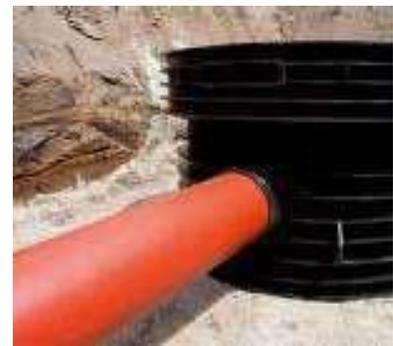
Bei einem Anschluss an Wavin Schächte wie beispielsweise das Tegra Sehachtsystem werden diese direkt mit vollwertigen Kugelgelenkmuffen ausgeliefert. Ein Rohranschluss ist dann mühelos analog zu der Herstellung von Rohrverbindungen durchzuführen. Andere Sehachtsysteme müssen z. B. durch entsprechende Sehachtfutter eine Anschlussmöglichkeit für glattwandige, genormte Rohrsysteme bieten.
