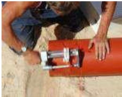
Das Spitzende des Acaro PP Rohres ist gemäß DVS 2207-11 vorzubereiten. Hierzu ist das Rohr rechtwinklig abzutrennen und mit einem geeigneten Schälgerät im Bereich der Schweißzone zu bearbeiten. Späne und sonstige Verunreinigungen sind zu entfernen. Die Einstecktiefe ist anzuzeichnen.
