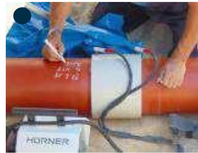
Das Formstück wird, ohne zu verkanten, auf das Rohr gesteckt. Hierbei ist die Einstecktiefe zu beachten. Die Schweißkontakte werden mit dem Schweißgerät verbunden und der Barcode eingelese, um die Schweißung zu starten. Die Schweißparameter werden neben dem Formteil auf dem Rohr festgehalten.
