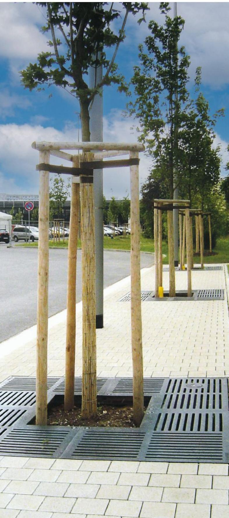
Bäume benötigen in den ersten beiden Jahren eine Verankerung. Diese muss auf den Wavin TreeTank abgestimmt sein. Bei der Wahl einer oberirdischen Baumverankerung empfiehlt sich ein tief eingeschlagener Dreibock, bei der Wahl einer unterirdischen Baumverankerung eine Ballenverankerung für Objektbegrünungen. Alle Systeme müssen oberirdisch und unterirdisch verletzungsfrei eingebaut werden. Baumverankerungssysteme sind nicht im Lieferumfang von Wavin enthalten.
