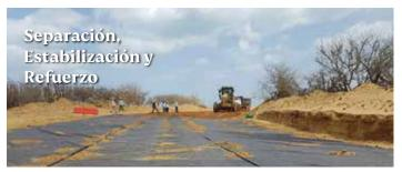
Las actividades de mineras ocurren en general, en áreas remotas que requieren la construcción de caminos y plataformas de trabajo estables, en ocasiones con baja capacidad de soporte. Para permitir la construcción de estas, se pueden utilizar Geosintéticos con diferentes funciones para la separación de materiales, estabilización de subrasantes y refuerzo de capas granulares.
