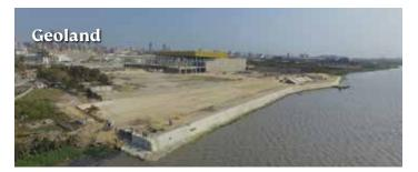
Es un sistema flexible desarrollado a partir de la combinación apropiada de Geosintéticos permiten la generación de áreas planas en espacios en terrenos montañosos o en presencia de cuerpos de agua, con esta aplicación se pueden construir zonas de acceso o áreas adicionales dentro de los relaves, estructuras de contención, refuerzo y control de erosión.
