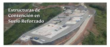
Son estructuras autoportantes que garantizan los criterios de seguridad y estabilidad del proyecto, estas soluciones son ideales para reemplazar el uso de materiales tradicionales como el concreto y el gavión, y pueden generar ahorros de hasta un 30% debido a la posibilidad de utilizar material local. Función: Refuerzo, contención y estabilización.
