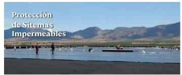
Los Sistemas de Impermeabilización con Geosintéticos pueden reducirse a causa de las solicitudes de esfuerzos localizados de tracción, punzonamiento y desgarro, por el contacto con materiales de diferentes tamaños se recomienda que en el sistema de impermeabilización se utilice Geotextiles No Tejidos de alta resistencia como protección de Geomembranas.
