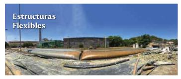
Son geoformas de diferentes dimensiones fabricadas con Geotextiles Tejidos de alto desempeño, que se adaptan a las condiciones especiales de cada proyecto. Estas estructuras se pueden llenar con distintos materiales disponibles en la obra y se pueden instalar en condición seca o sumergida. Función: Control de Erosión, Secado de Lodos, Bases de estructuras.
