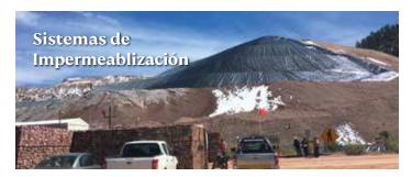
Son sistemas para la contención de líquidos u otros fluidos, lo cual se logra a través de la utilización de Geomembrana y GCL, con el fin de proteger los recursos subterráneos y el nivel freático del suelo para evitar su contaminación, se utilizan en la recuperación de productos químicos. Función: Impermeabilización.
