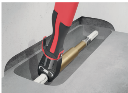
Kuva 30: Korjausliittimien asennusvaiheet.
