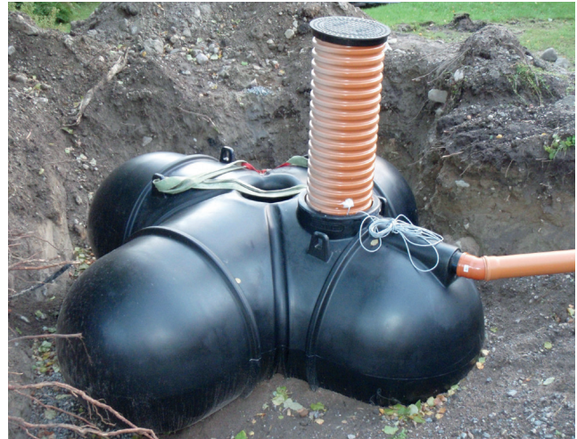
Installation av Wavin slutna tank 3 m 3 I PE
