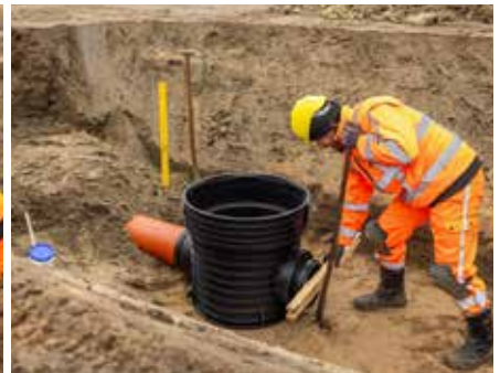
4. Puhdista putken pää ja tee siihen viiste. Levitä muhviin liukuainetta. Aseta kaivo putken päähän ja työnnä kaivoa, kunnes muhvi on putken asennusmerkinnän kohdalla. Käytä puukalikkaa välissä, kun työnnät kaivoa.
