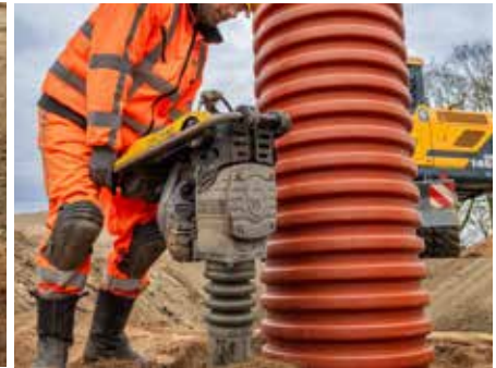
12. Tee maatayttö ja tiivistys InfraRYL:n mukaisesti. Täyttökerroksen korkeus tiivistysten välillä saa olla enintään 30 cm.
