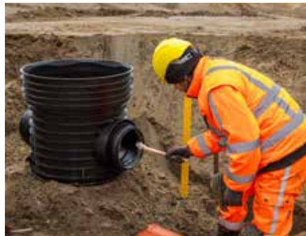
4. Puhdista putken pää ja tee siihen viiste. Levitä muhviin liukuainetta. Aseta kaivo putken päähän ja työnnä kaivoa, kunnes muhvi on putken asennusmerkinnän kohdalla. Käytä puukalikkaa välissä, kun työnnät kaivoa.
