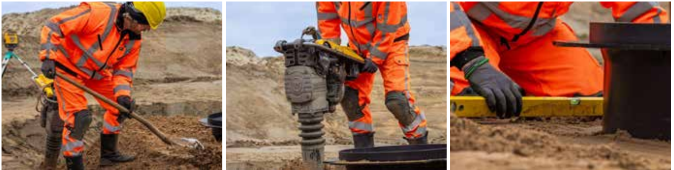
16. Tasoita ja tiivistä maa kannen ympärillä lopulliseen korkeuteen.
