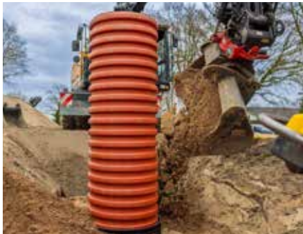
12. Tee maatayttö ja tiivistys InfraRYL:n mukaisesti. Täyttökerroksen korkeus tiivistysten välillä saa olla enintään 30 cm.
