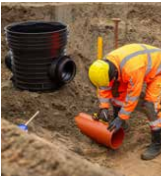
3. Mittaa liitosmuhvin syvyys ja tee putkeen vastaava asennusmerkintä.
