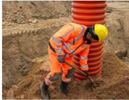
12. Tee maatayttö ja tiivistys InfraRYL:n mukaisesti. Täyttökerroksen korkeus tiivistysten välillä saa olla enintään 30 cm.
