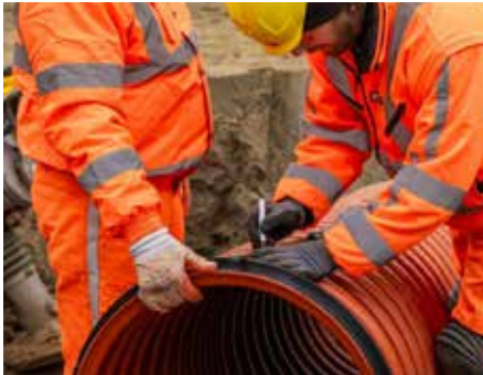
11. Mittaa liitosmuhvin syvyys ja tee nousuputkeen vastaava merkintä. Työnnä nousuputki sen jälkeen kaivopohjaan.
