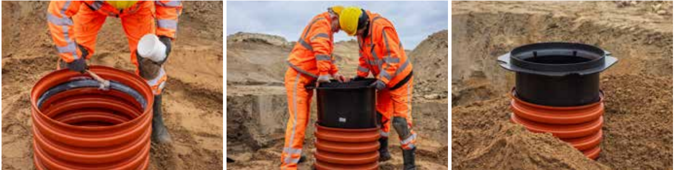
15. Levitä liukuaine ja työnnä kehys ja mahdollinen teleskooppi paikalleen.
