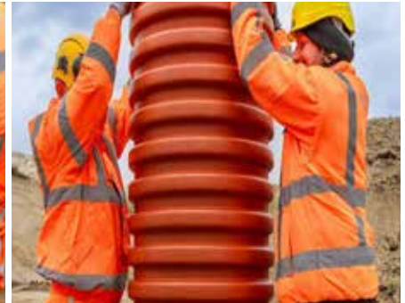
11. Mittaa liitosmuhvin syvyys ja tee nousuputkeen vastaava merkintä. Työnnä nousuputki sen jälkeen kaivopohjaan.
