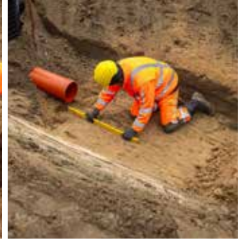
2. Suorista kaivannon pohja. Ota huomioon kaivon pohjan ja putkiliitoksen välinen korkeusero.
