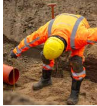
2. Suorista kaivannon pohja. Ota huomioon kaivon pohjan ja putkiliitoksen välinen korkeusero.
