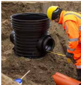
3. Mittaa liitosmuhvin syvyys ja tee putkeen vastaava asennusmerkintä.
