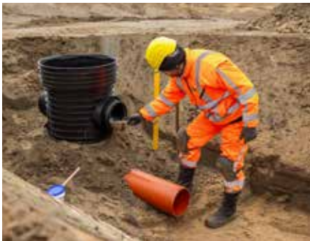
4. Puhdista putken pää ja tee siihen viiste. Levitä muhviin liukuainetta. Aseta kaivo putken päähän ja työnnä kaivoa, kunnes muhvi on putken asennusmerkinnän kohdalla. Käytä puukalikkaa välissä, kun työnnät kaivoa.
