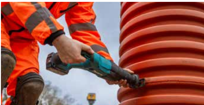
13. Katkaise nousuputki oikeaan pituuteen.
