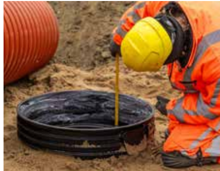
11. Mittaa liitosmuhvin syvyys ja tee nousuputkeen vastaava merkintä. Työnnä nousuputki sen jälkeen kaivopohjaan.
