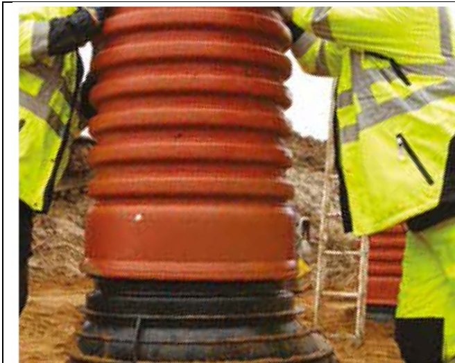
Pres Tegra 600 opføringsrør på plads.
