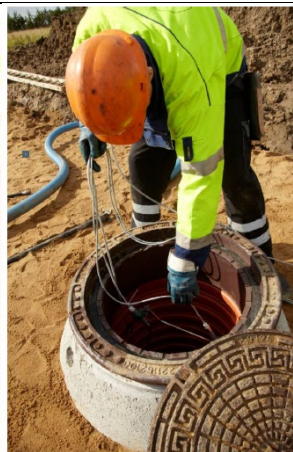
Skær Tegra 600 opføringsrøret af i korrekt højde, installer alarm og inddækning i henhold til gældende regler.
