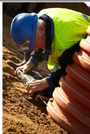
Skær Tegra 600 opføringsrøret af i korrekt højde, installer alarm og inddækning i henhold til gældende regler.
