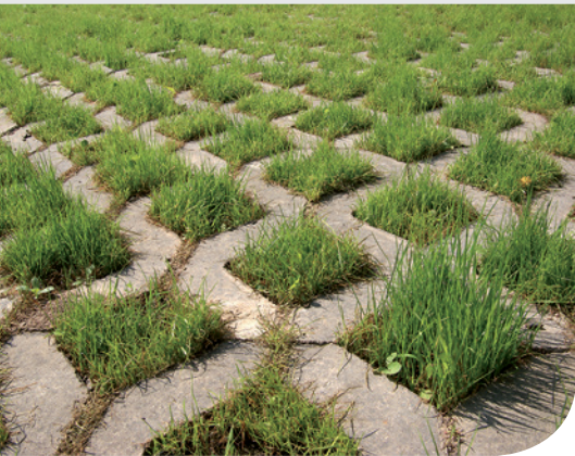
Tvarus nusausinimas: pralaidūs šaligatviai, kelkraščiai ir sodai. Paveiksle pavaizduotas pusiau atviras šaligatvis su žole.
