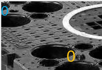
Sollten es die statischen Anforderungen erfordern, kann die Hochlastausführung auch in den nachfolgenden Lagen umgesetzt werden. Hierzu wird der o.g. Arbeitsschritt einfach wiederholt. Stifte und Öffnungen auf der Oberseite des Hohlkörpers sorgen für einen verschiebesicheren Aufbau der nächsten Lage.
