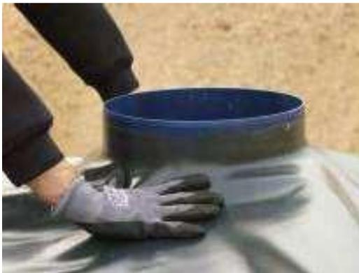
Auch im Bereich der Schachtheadapter ist das Vorgehen identisch. Der Vliesstoff wird kreuzförmig eingeschnitten und über den Adapter geschoben. Auch hier ist darauf zu achten, dass es keine Risse oder Öffnungen gibt, durch die Verfüllmaterial in die Rigole gelangen kann.
