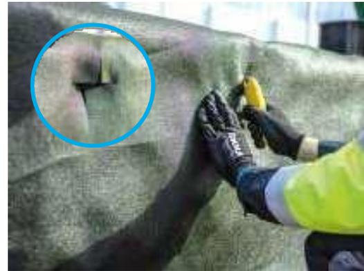
Wird der Anschluss DN/OD160 direkt in der Seitenplatte gesetzt sind die Vliesecken vom Kreuzschnitt mit dem Anschlussrohr sorgfältig und ohne Risse in den Versickerungshohlkörper mit einzudrücken. Für einen sauberen Abschluss wird empfohlen, ein weiteres Stück Vliesstoff über das Rohr zu schieben, um einen ordentlichen und Sanddichten Abschluss garantieren zu können.
