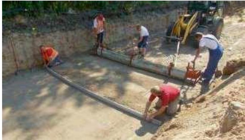
Der empfohlene Arbeitsraum für den Einbau der Rigole kann überschlägig durch die Rigolenlänge und -breite zuzüglich eines Mindestarbeitsraums von 1,00 m definiert werden. Der Arbeitsraum ist derart auszustatten, dass die Rigole rundum bis auf die Baugrubensohle zugänglich ist und die Verdichtung nach dem Einbau fachgerecht erfolgen kann.
