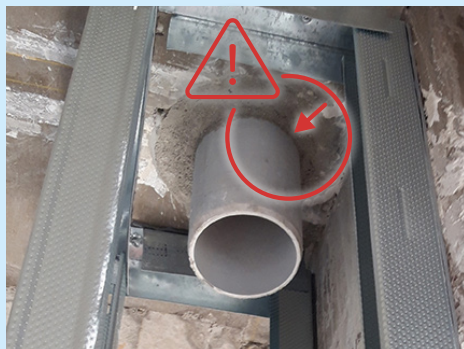
Figura 20: Desacoplamiento olvidado.
