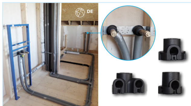
Figura 36: Conjuntos de aislamiento acústico.
