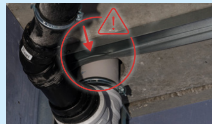
Figura 41: Evitar el contacto con perfiles.
