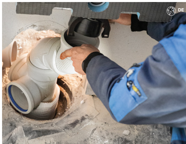
Figura 42: Configuración de un sistema sanitario para una losa de piso.
