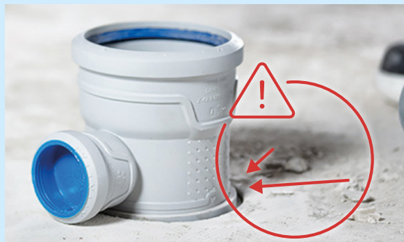
Figura 21: Los escombros de la construcción como un puente de sonido transmitido por la estructura.
