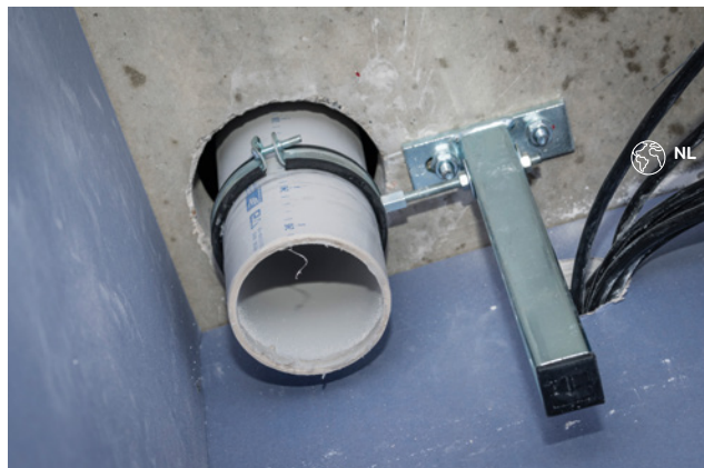
Figura 11: Fijación a elementos que contienen masa.
