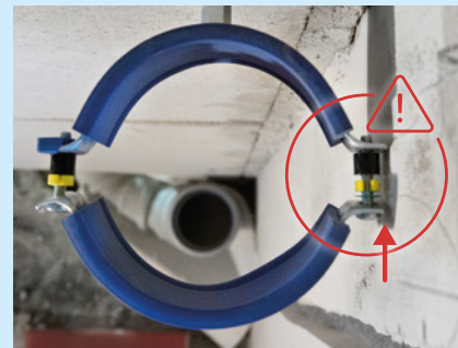
Figura 40: Alineación correcta de los soportes de tubería.
