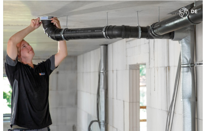
Figura 39: Tubería de aguas residuales con aislamiento acústico.
