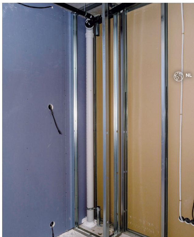
Figura 12: Paredes de lámina de yeso con fijación mediante escuadras a techo y suelo.
