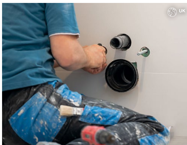
Obrázek 43: Příprava instalace keramiky
