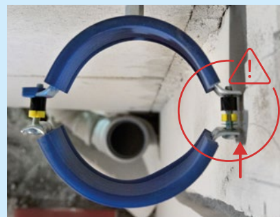
Obrázek 40: Správné srovnání trubkových objímek
