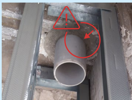
Obrázek 20: Zapomenuté přerušení akustické vazby pro přenos zvuku tělesy
