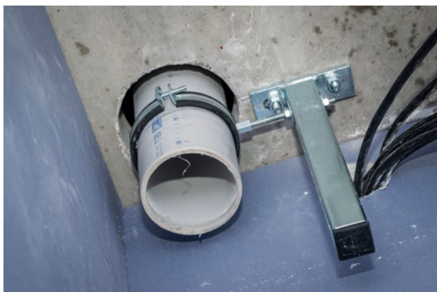
Obrázek 11: Upevnění na masivní prvky
