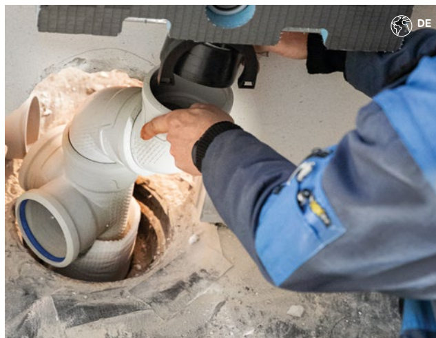
Obrázek 42: Sestava rozvodu odpadů v podlahové desce
