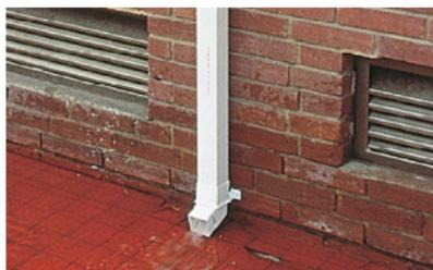
**04.** Acople un codo de 45° al extremo de la bajante cercano al piso, de manera de descargar el agua de lluvia al patio o jardín.
