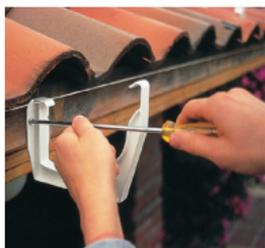
**04.** Coloque los soportes a una distancia, entre sí, menor de 75 cm. Utilice como guía la cuerda nivel, la cual debe apoyar sobre el extremo superior interior del soporte plástico.
