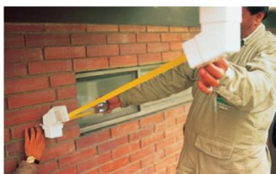
**02.** Utilice los codos a 45° y 90° para dirigirla hacia la pared donde puede sujetarse. (Recomendamos utilizar adhesivos Amanco al usar ambos codos).
