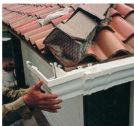
**05.** Si la instalación requiere unión esquina (interior o exterior) coloque soportes lo más cercano posible a dicha unión, pues esta conexión no se atornilla al muro.
