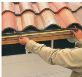
**01.** Verifique la nivelación del muro donde se fijarán los soportes. Recuerde que debe respetarse el nivel horizontal.
