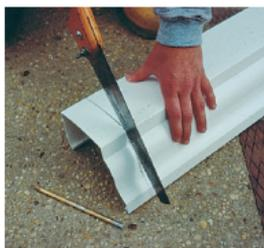
**06.** Tome las medidas de los tramos de canaleta a instalar. De ser menor a 3 m, simplemente corte el sobrante. Si es mayor utilice la unión de canaletas.
