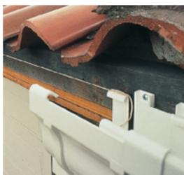
**02.** Tire una cuerda nivel desde el inicio de la instalación hasta el sitio donde se colocará la unión de canaleta a bajante.
