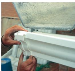
**08.** Ensamble el canal ajustando primero el lado interno, y luego el externo. Verifique que el extremo de la canaleta llegue hasta la indicación que figura en el accesorio.
