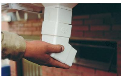
**01.** Una vez que la canaleta esta fija al muro, acople la bajante a la unión con embudo a la bajante.
