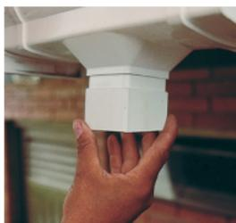
**03.** Fije al muro la unión con embudo a bajante, alineando sus orificios con la cuerda nivel.
