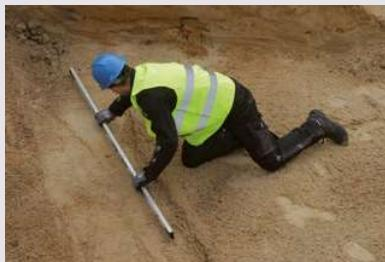
Před montáží je nutné srovnat a zpevnit lože vsakovacího či retenčního objektu. Pro finální srovnání je vhodné použít štěrk nebo hrubý písek. Šířka výkopu ve dně musí být cca o 1 m širší než je rozměr sestavy. Při montáži je nutné dodržovat bezpečnostní předpisy pro práci ve výkopu (pažení, svahování atd).
