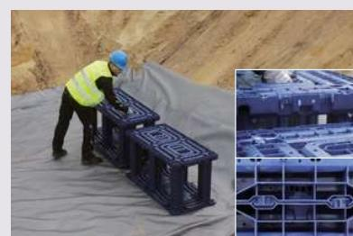
Sestava se skládá dle montážního schématu a jednotlivé boxy se do sebe „zamykají“ integrovanými zámky ve dvou sousedících stranách. K montáži nejsou nutné další nástroje nebo spojovací elementy.
