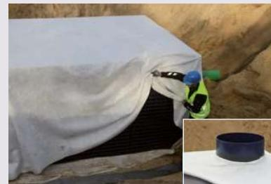
Celá sestava se dokončí obalením geotextilie nebo hydroizolačním souvrstvím při splnění montážních předpisů.
