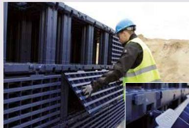
Boční desky se zavěšují do připravených otvorů, které jsou mezi fixačními pouzdry pro spojování boxů vedle sebe a fixují se (klikem) na nosné pilíře.
