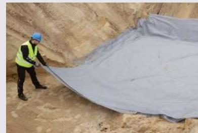
Na rovinu výkopu se roztáhne geotextilie s dostatečným přesahem min. 0,2 m na jednotlivých spojích.
