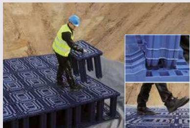
Při skládání druhé nebo další vrstvy se akumulační boxy fixují bez základové desky přímo na horní stranu spodní vrstvy. Opět se 6 pilířů fixuje do předpravených pouzder a boční pouzdra se u sousedících boxů zamykají.
