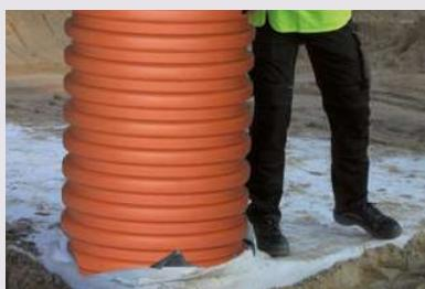
Na připravené šachtové adaptéry se osazují šachtové roury daného průměru a hutnění probíhá postupně nad sestavou. První vrstva se hutní vibracemi až po dosažení min. 60 cm v celé ploše výkopu.
