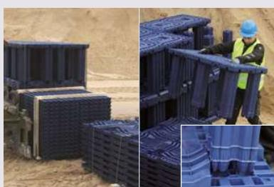
Jednotlivé komponenty systému Q-Bic Plus si připravte v blízkosti stavební jámy. Akumulační box se fixuje pomocí 6 svislých pilířů do základové desky. Základové desky jsou pro vsakovací a retenční nádrže odlišné.
