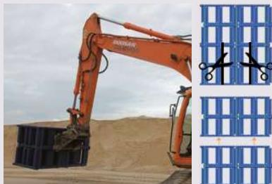
Palety jsou staženy na dvou místech upínacími pásy různé barvy podle pořadí, ve které se mají pásky demontovat. Na jedné paletě je tak 32 ks akumulačních boxů.
