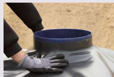
U retenčních nádrží je nutné dbát zvýšené pozornosti na opracování vstupních hrdel (nátoků, odtoků) a revizních šachet hydroizolační fólií.
