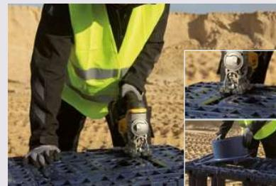
Pro osazení revizních šachet je nutno na definovaných místech provést prořezání konstrukce a osadit šachtový adaptér požadovaného průměru pro šachty 315, 425 nebo 600. Tyto otvory jsou označené značkou pilky a jsou v místě ergonomického madla na každém boxu.
