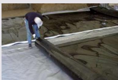
Při montáži retenčních nádrží se na dno výkopu postupně rozkládají ochranné geotextilie, PVC (nebo HDPE) fólie a vnitřní ochranná geotextilie. Montáž fólie musí provádět odborná firma s oprávněním k izolaci tlakové vody.
