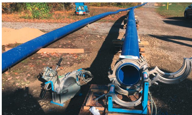
Heizwendelstumpfschweißung
