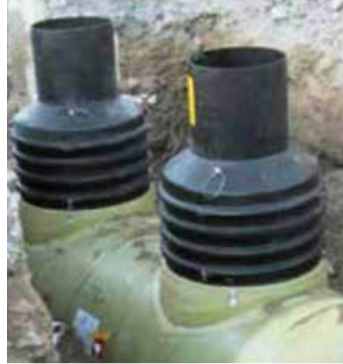
Şekil 7: EuroHUK 600 muayene bacası uygulaması
