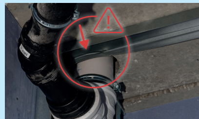
Figura 41: Evitamento del contatto con i profili
