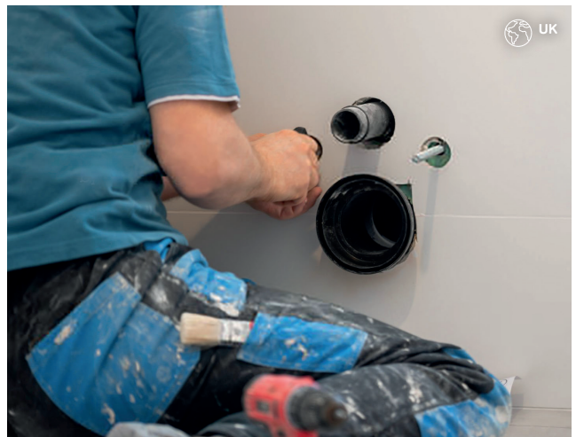
Figura 43: Preparazione dell'installazione dei sanitari
