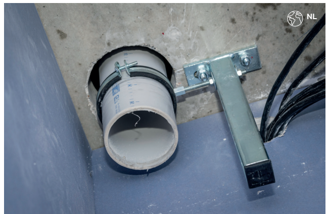
Figura 11: Fissaggio ad elementi contenenti massa
