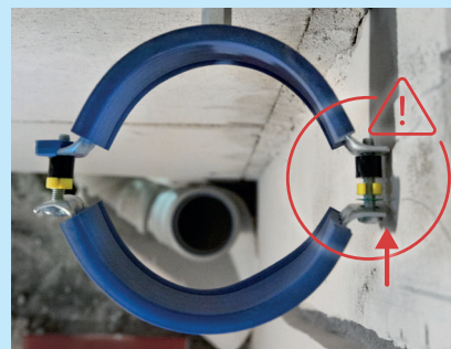
Figura 40: Allineamento corretto delle staffe dei tubi
