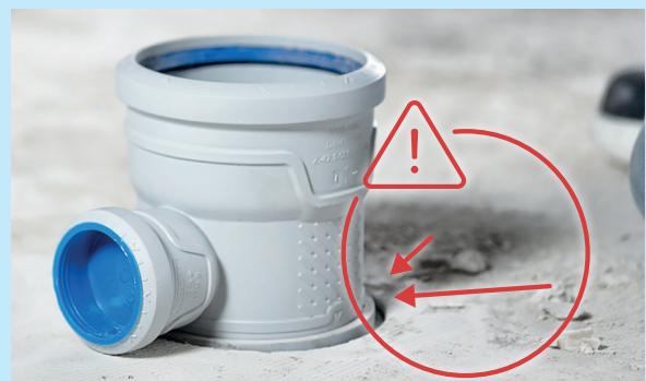
Figura 21: Detriti da costruzione come ponte acustico strutturale
