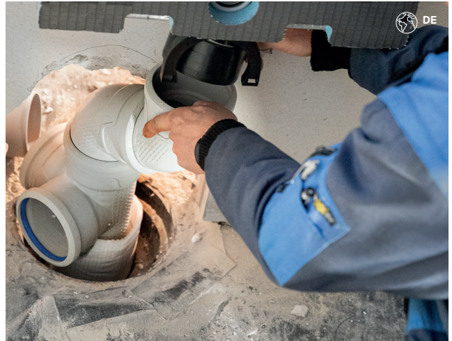
Figura 42: Realizzazione di un sistema fognario per una soletta
