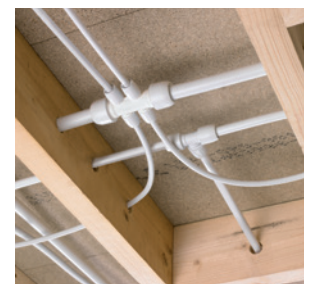
Afb. 5.22: Hep 2 O is gemakkelijk aan te leggen bij houten balken. De leidingen kunnen gewoon door de geboorde gaten worden getrokken.
