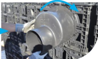
Pour un DN400, découper les plaques latérales en deux et positionner les demie-plaques nécessaires (Figures 2), positionner toutes les plaques latérales, placer les connexions sur les lignes et les couches souhaitées en positionnant les centreurs hauts et bas, (Figures 3) et fixer la connexion à l'aide des 4 vis fournies (Figure 4).
