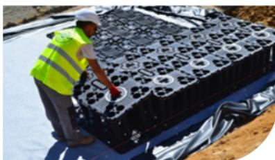
Installer les modules Wavin AquaCell les uns à côté des autres (Logo Wavin vers le haut) dans le même pas de pose.
