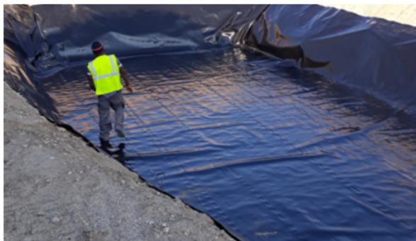
La mise en œuvre devra respecter les “Recommandations générales pour la réalisation d’étanchéités par géomembranes du Comité Français des Géotextiles et géomembranes” (Fascicule N° 10 – 1991) et au guide de 2001 du SETRA / LCPC « Etanchéité par géomembrane des ouvrages pour les eaux de ruissellement routier ».
