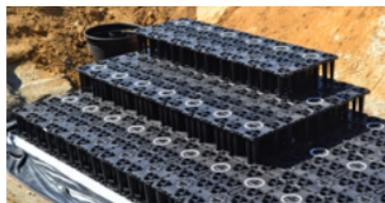
Dans le cas de l'utilisation des modules renforcés, le connecteur d'inspection de couleur beige (cf. photo ci-contre) doit être aligné avec les ronds (anneaux blancs) des modules standards.
