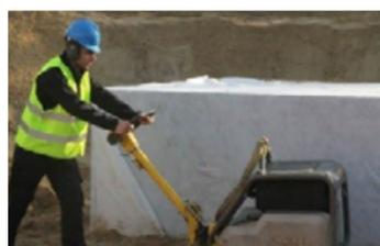
L'usage d'une pilonneuse vibrante de classe PN3 ou à percussion de classe PP2 (Cf. NF P 98-736 Tableau 8) est recommandé pour cette opération.
