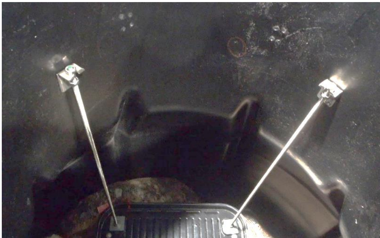
Kuva 16. Jakoaltaan kierretankojen kiinnitys huoltokaivoon.
