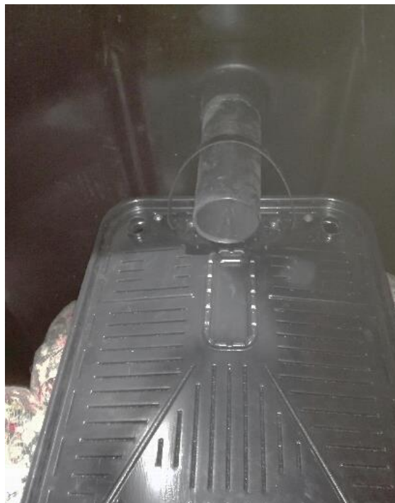
Jakoaltaan asennus BioPlus -puhdistamon sisälle.
