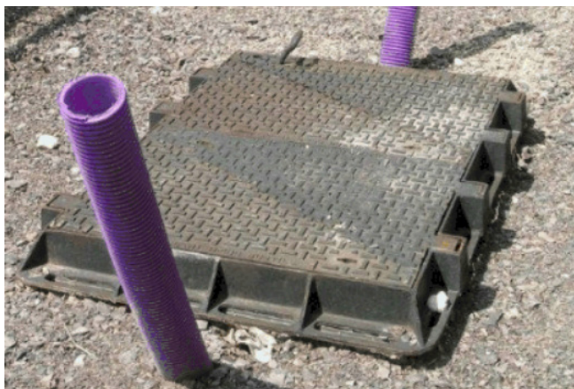
40 tons dæksel ved installation i Sverige.
