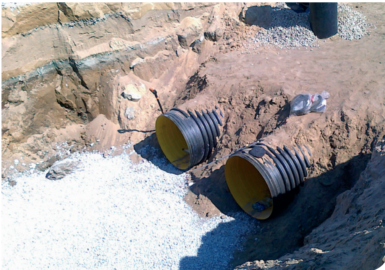
Installation av XL rör (DN/ID1000) i anläggningsområdet
