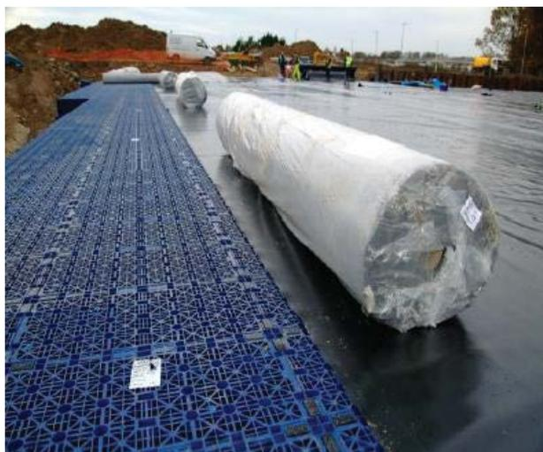
Para la aplicación de almacenamiento, el sistema se envuelve con una Geomembrana de 40 mils, protegida con un Geotextil AMANCO WAVIN NT 3000
