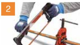
Cortar el tubo a escuadra y remover las rebabas con lija o cuchillo. Se recomienda el uso de una tijera corta tubo o una sierra para realizar corte a escuadra.
