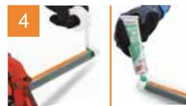
Aplique una capa uniforme de Sellarosca Plastigama Wavin, luego aplique cuatro vueltas de Teflón Plastigama Wavin, y finalice con otra capa uniforme de Sellarosca Plastigama Wavin, tipo "Sanduche". Evite el uso excesivo de teflón, esto podría provocar daños en el accesorio; sin embargo en el buen criterio del instalador para diámetros mayores a 1/2" podrá usarse más de 4 vueltas de teflón.
