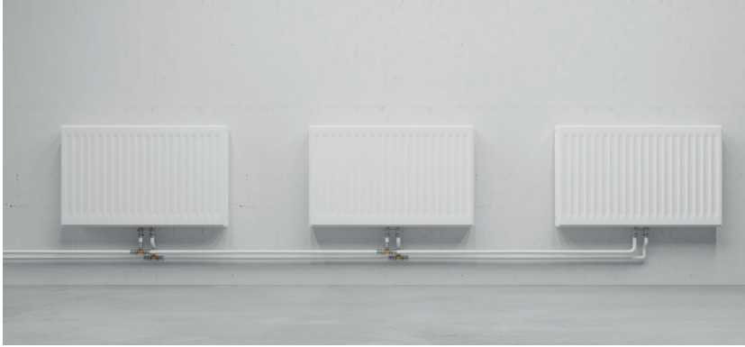
Fig. 42: Sistema di distribuzione a due tubi (standard).
