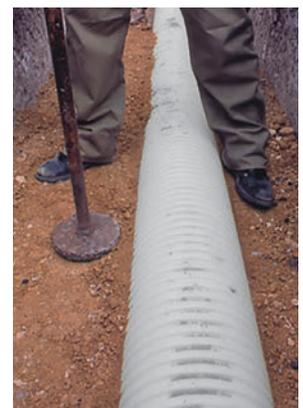
Novafort es un tubo de PVC No Plastificado (PVC-U) de superficie interior lisa y exterior perfilada, especialmente diseñado para redes y colectores cloacales, pluviales o industriales.
