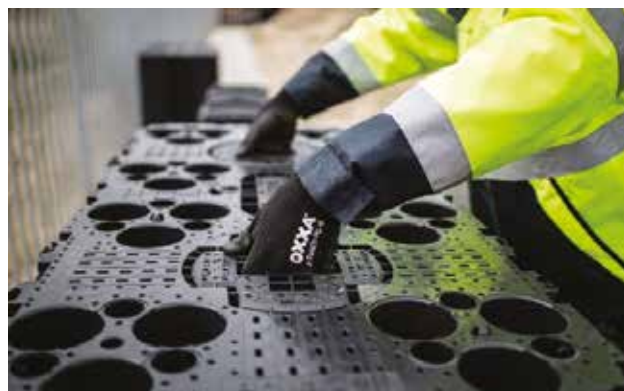
Rys. 9.2.4. Montaż zbiornika AquaCell 400 - ergonomiczne uchwyty.
