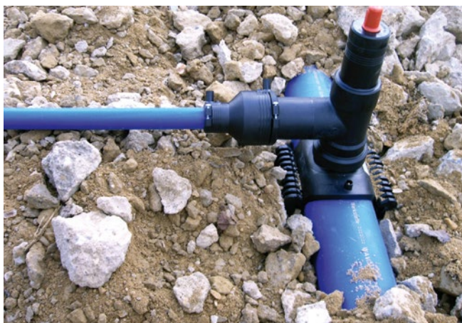
Porovnání svařování elektrotvarovkami a metodou na tupo
