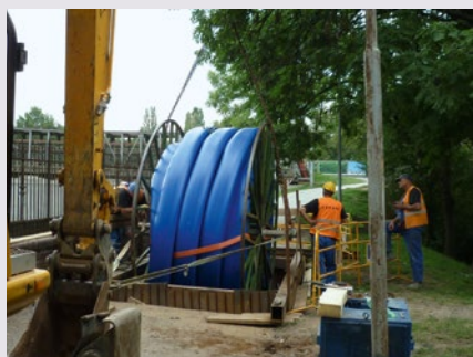
Sanace ocelového vodovodu DN 500 v centru na Prašném Mostě v Praze proběhla v extrémně krátké době do zprovoznění
