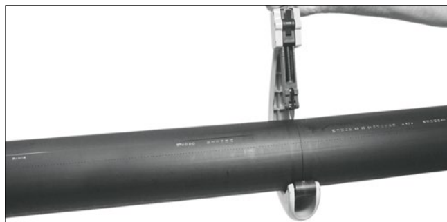
Řez potrubí ruční rotační řezačkou
