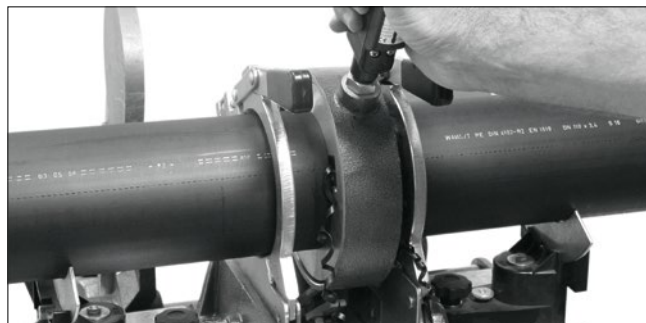
Srovnání konců potrubí integrovaným hoblíkem
