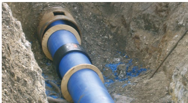
Sanace ocelového vodovodního potrubí DN 300 technologií Relining ve Štětí
