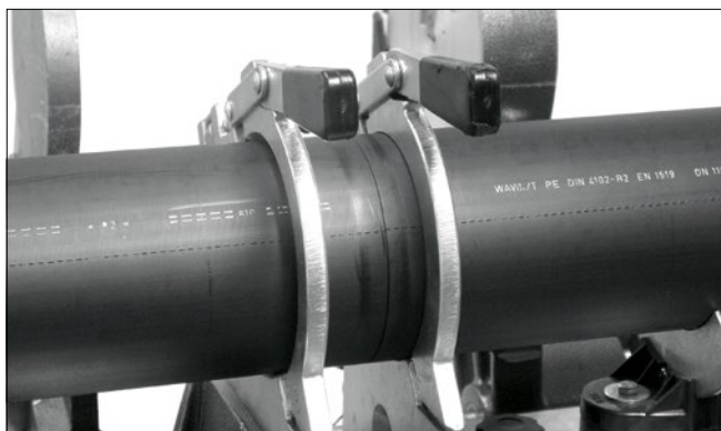
Správně připravené potrubí ke svařování
