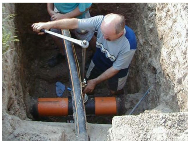
Vysazení přípojky pomocí sedlové tvarovky
