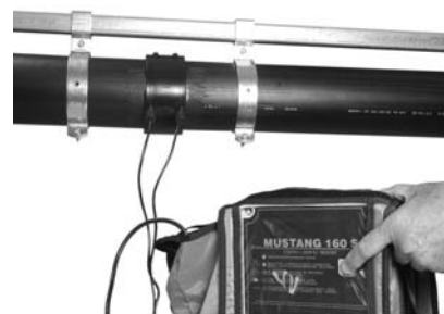
Afbeelding 56 Goede bevestiging vóór het lassen
