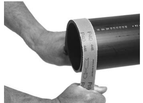
Afbeelding 50 Leiding schuren met schuurlint korrel 40 of minder
