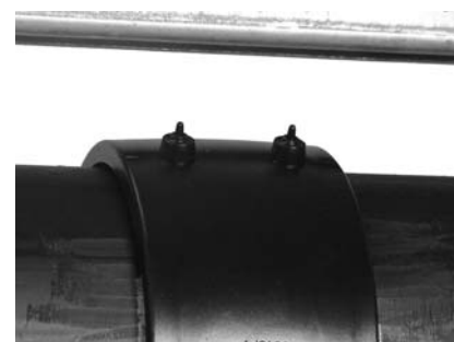
Afbeelding 57 Inspecteren van insteekdiepte en lasindicatoren
