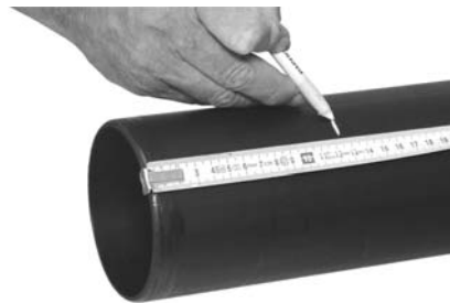
Afbeelding 59 Installatie van een expansiemof.
