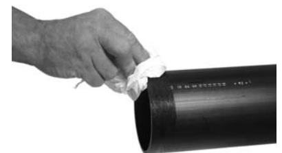
Afbeelding 52 Buiseinde reinigen met PE reiniger
