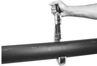
Afbeelding 50 Leiding schuren met schuurlint korrel 40 of minder
