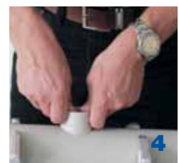
4 Helyezze a felmelegített nyeregidomot a felmelegített furatba és rögzítse kb. 16 másodpercig. Egy órával később már nyomás alá lehet helyezni, rá lehet engedni a vizet.
