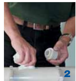
2 Tisztítsa meg. Amennyiben Stabi csövet használ, sarkítsa le a fúrt lyuk élét. Tisztítsa meg és zsírtalanítsa a hegesztőpárt, a csövet és a kifúrt lyukat.
