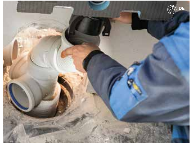
Rysunek 42: Wykonanie przejścia rur kanalizacyjnych przez płytę stropową
