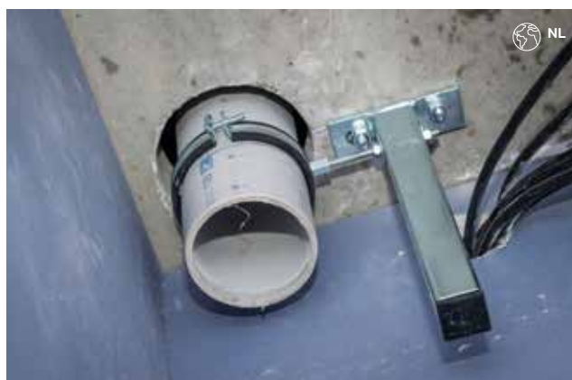
Rysunek 11: Mocowanie do elementów składowych konstrukcji
