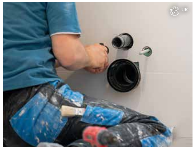
Rysunek 43: Przygotowanie do montażu ceramiki
