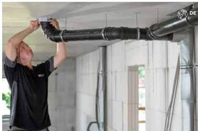
Rysunek 39: Rura kanalizacyjna w elastycznym przewodzie izolacyjnym
