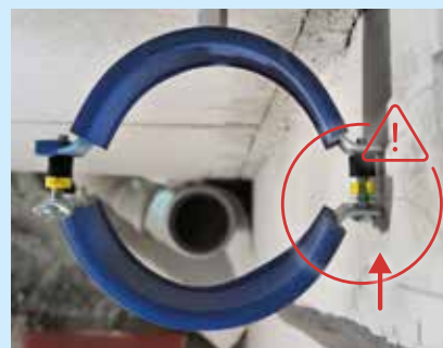
Rysunek 40: Prawidłowe ustawienie wsporników rurowych
