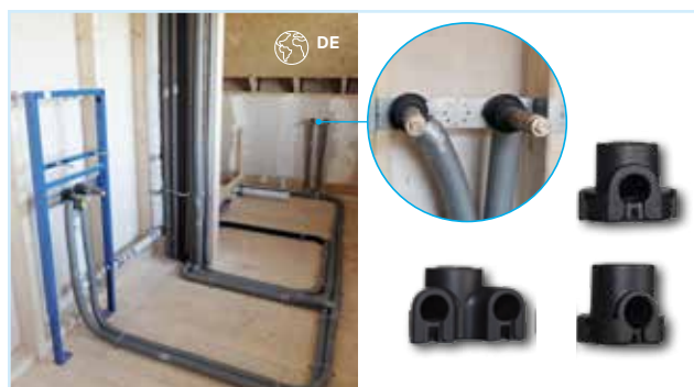
Rysunek 36: Zestawy izolacji akustycznej
