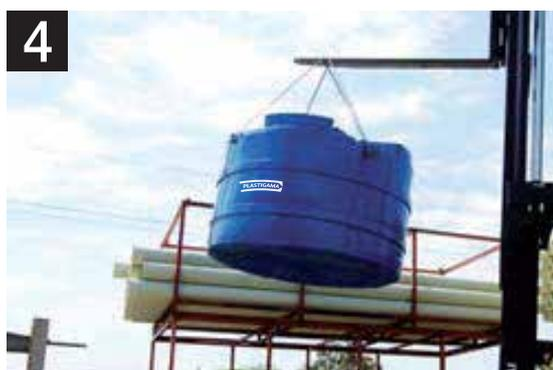
4 Levante el tanque de los tirantes en sentido vertical, con tecle o polea.
