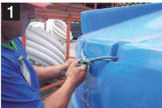
1 Amarre con un lazo en forma segura la caja de anclaje del tanque con el cabo de nylon. A continuación pase el cabo por debajo del tanque para amarrar la ceja opuesta.
