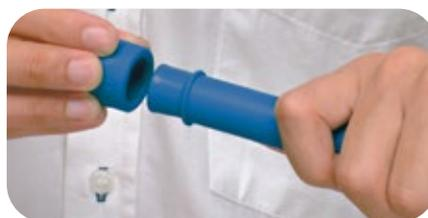
Após a termofusão da conexão com o tubo, segure firme durante 20 a 30 segundos. Durante um intervalo de aproximadamente 3 segundos, existe a possibilidade de alinhar a conexão em até 15° (não gire).
