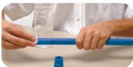
Marque na extremidade do tubo a profundidade da bolsa da conexão.
