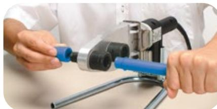
Após retirar o tubo e a conexão do termofusor, introduza imediatamente a ponta do tubo na bolsa da conexão até a marcação realizada anteriormente. Respeitar o intervalo para acoplamento conforme tabela de tempo de termofusão.
