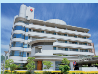
Otro tipo de infraestructura con grandes superficies de techo
